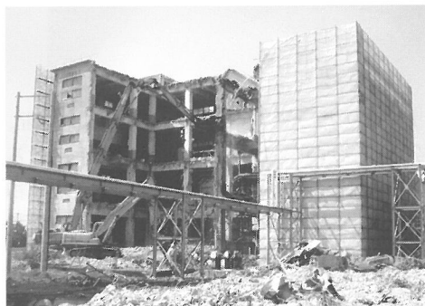
大型解体現場の工事風景
